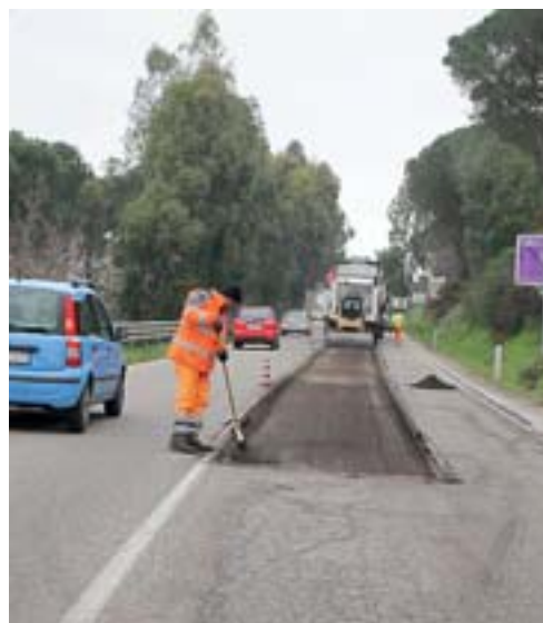
Nuovo asfalto all'ingresso della città [M. L.]
